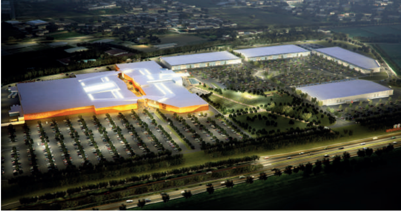
ELEVATOR TANK Centro Commerciale MondoJuve TORINO, ITALIA
