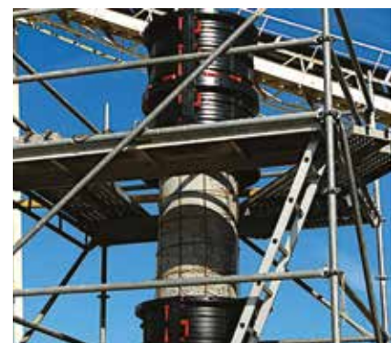
RENOVACIÓN DE COLUMNAS
