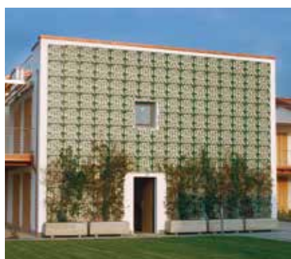
MUROS VERDES VERTICALES
