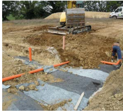
⑤ POSE DU GÉOTEXTILE Pose du Géotextile sur toute la surface.
