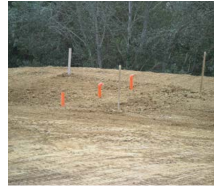
⑥ COUVERTURE Couverture avec terre jusqu'au niveau du site.
