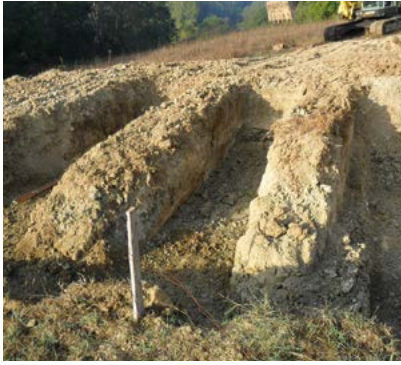
① EXCAVATION Excavation d'une tranchée large au moins 90 cm à la base.
