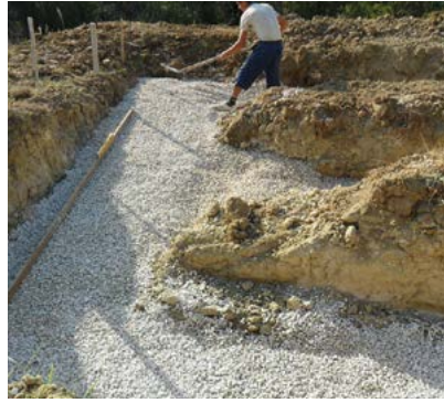
② POSE DU GRAVIER Remplissage avec gravier 20/40 mm (épaisseur minimale 10 cm).
