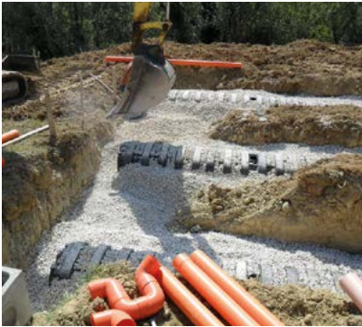
④ REMBLAYAGE Insertion des tubes d'alimentation et d'aération. Recouvrement avec au moins 15-20 cm de gravier 20/40 mm.
