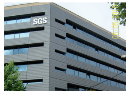
Edificio SGS en Barcelona.
