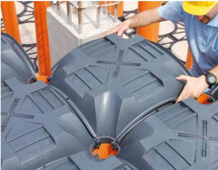
I casseri e le basi possono essere tagliati/sagomati in funzione delle caratteristiche di progetto. Le modifiche devono seguire le modalità indicate da Geoplast (si veda l'Appendice C) mediante l'uso di un flessibile o di una sega a disco.
