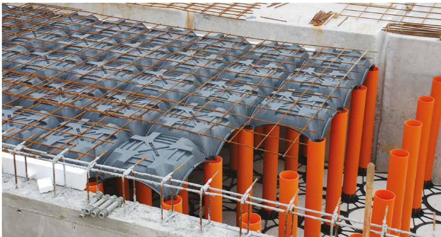
Modulares System zur Errichtung von Absetzungs- oder Auffangbecken für Wasser mit einem hohen Fassungsvermögen.
