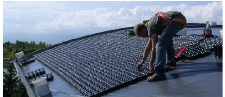
Figura 12 - Installazione Drainroof
