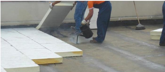
Figura 17 - Strato termoisolante
