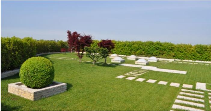
Figura 27 – Esempio di pensile intensivo
