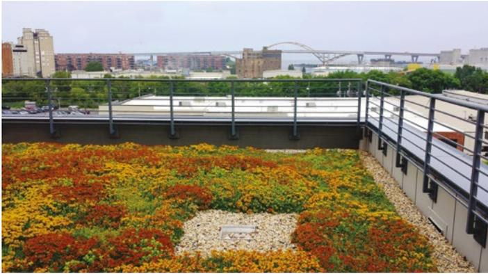
Figura 22 -Esempio pensile estensivo su copertura Industriale
