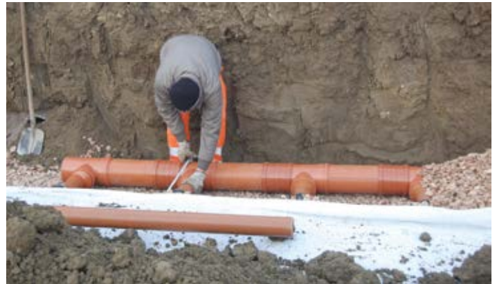
Figura 13 - Collettori per l'alimentazione del Drainpanel
