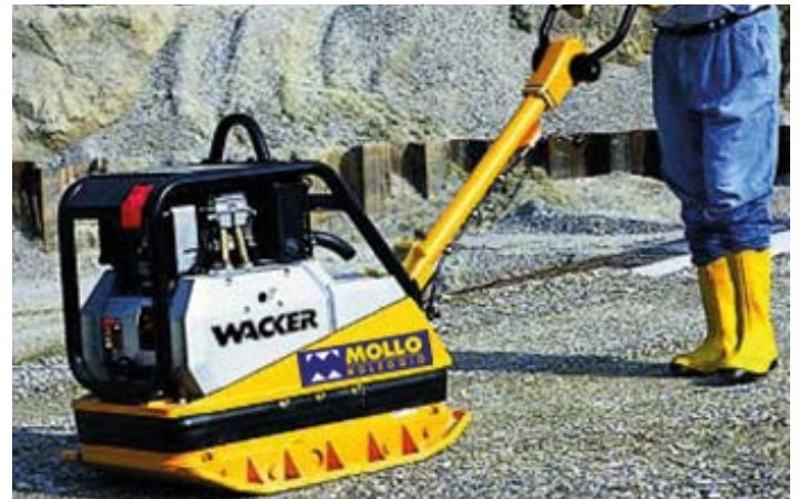
Figura 19 - Fase di compattazione del materiale di ricoprimento
