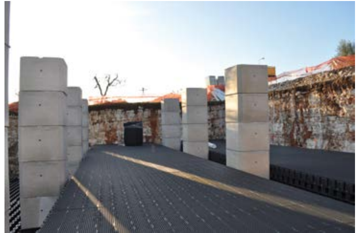
Figura 22 - Pozzetti per operazioni di pulizia bacino
