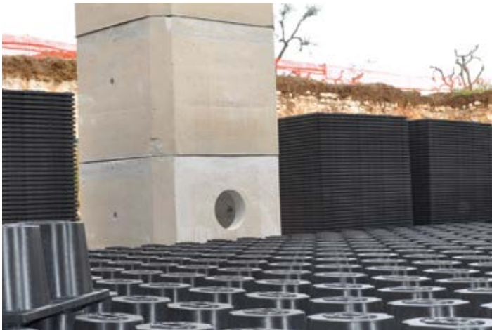
Figura 21 - Punto di accesso al sistema per l'ispezione
