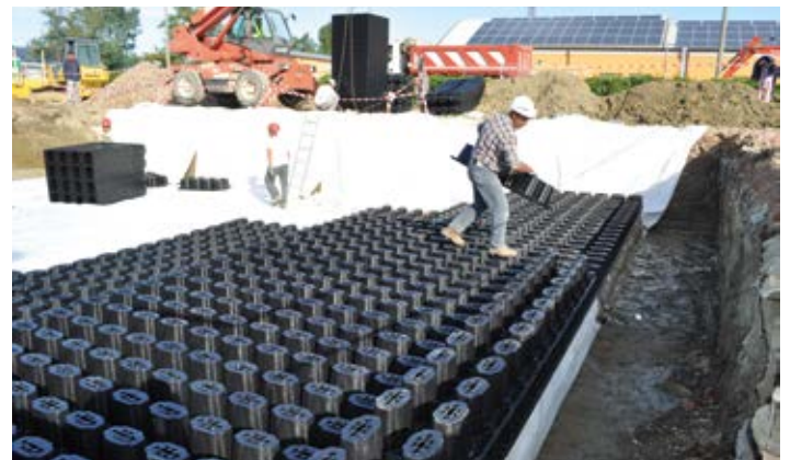
Figura 4 - Movimentazione Drainpanel
