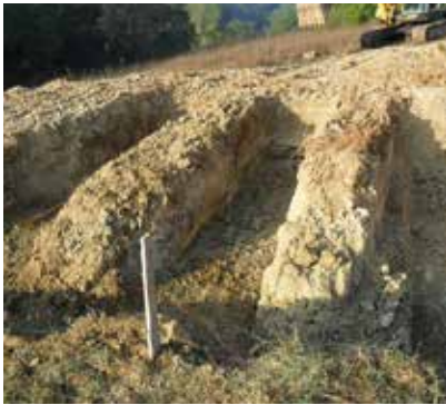
① EXCAVACIÓN Excavación de un banco de 90 cm en la base.
