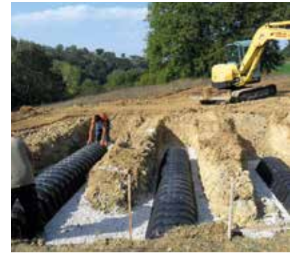
③ DRENING Instalación de las cámaras DRENING.
