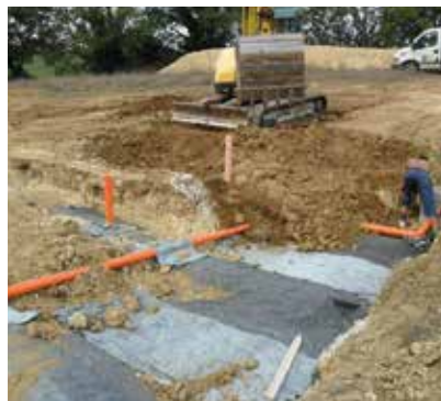
⑤ GEOTEXTIL Colocación del geotextil sobre toda la superficie.
