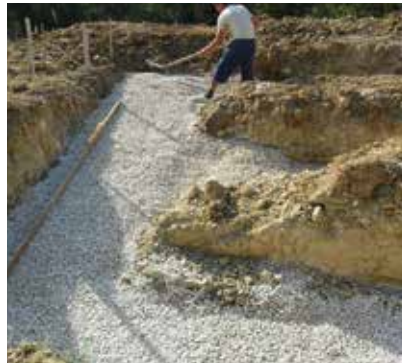
② CAPA DE GRAVA Capa de grava de 20/40 mm (espesor mínimo 10 cm).
