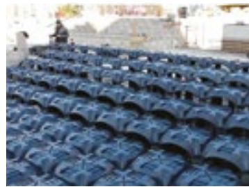
Detalle instalación de los encofrados
