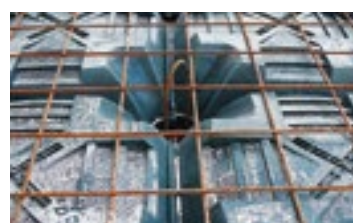
Refuerzo del pilar armadura
