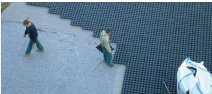
Figura 11 - Drainroof, instalación en obra
