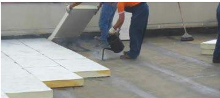
Figura 17 - Capa de aislamiento térmico
