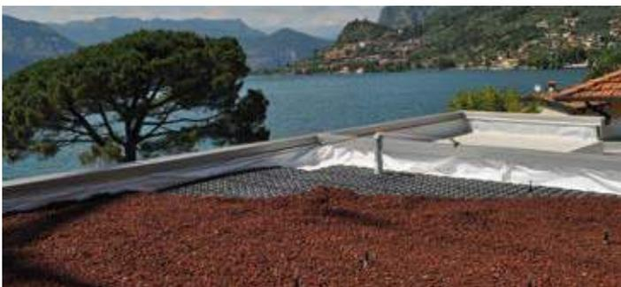
Figura 20 - Uso combinado del Drainroof y lapillius volcánico
