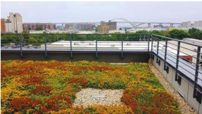
Figura 22 - Ejemplo de techo verde extensivo en un edificio industrial
