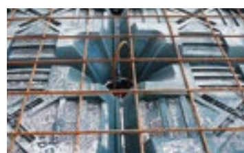
Verstärkung der Säulen mit Stahlgabeln
