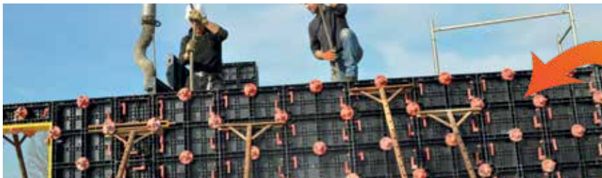
GETTO IN CALCESTRUZZO DEI MURI
