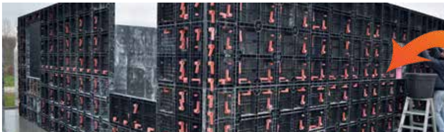
MONTAGGIO DELLE CASSEFORME PER MURI
