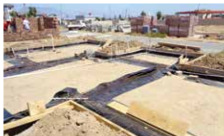
SCAVO, POSA DI CASSEFORME E TRAVI DI FONDAZIONE E ARMATURA
