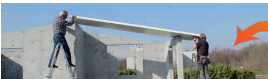
INSTALLAZIONE DI TETTO E TELAI
