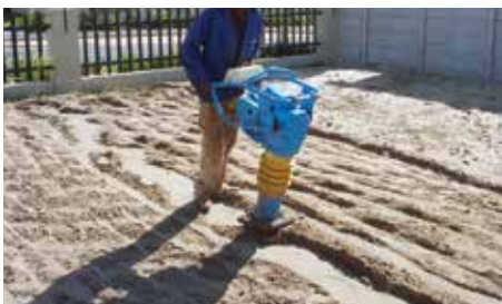
TRACCIATURA FONDAZIONE E COMPATTAZIONE SUOLO
