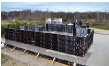
MONTAGGIO DEI PANNELLI
