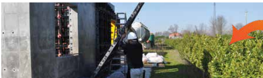
DISARMO DELLE CASSEFORME PER MURI
