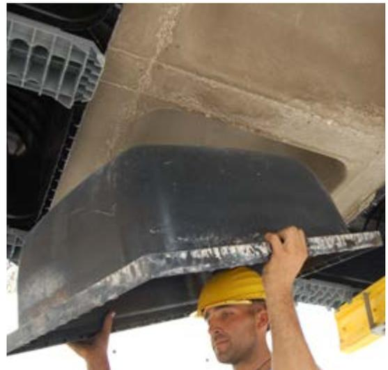
**1** Nach 6\7 Tagen von der Ausschaltung beginnt man, die Abschaltung des Systems **SKYDOME**, also nehmen Sie Stützen, Träger, **Würfel** und **Deckenträger aus ABS** ab. Die Operation wird immer von unten gemacht, deshalb arbeiten sie in Sicherheit.
