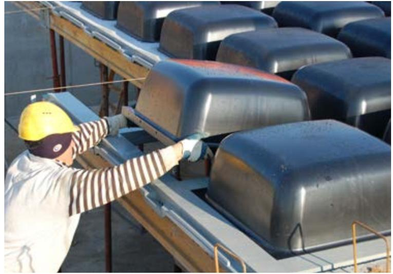
**1** Nach dem Bau der Stützesystem (Stützen + Träger) werden die Deckenträger und die Würfele aus ABS verlegt, um ein gleichmäßiges Gitter für die Verlegung der Kuppeln zu erstellen. Man kann die Verlegung der Kuppeln nach und nach dem Bau des Gitters durchführen.
