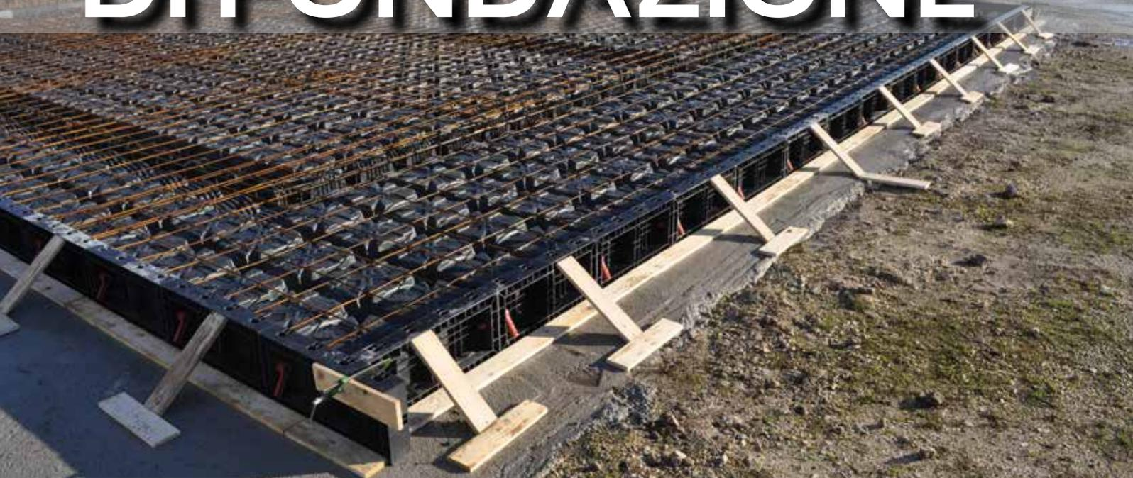
Sistema modulare a perdere per la realizzazione di fondazioni aerate usate come barriera fisica tra suolo ed edificio
