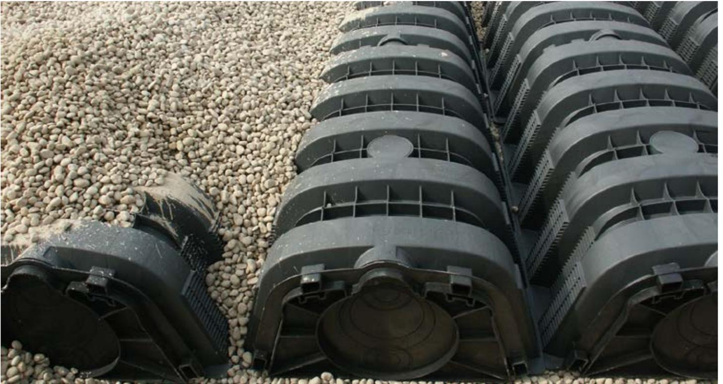
DRENING est un élément modulaire en PE HD, conçu pour réaliser des bassins enterrés pour le traitement des eaux pluviales “in situ”. Selon le type d’installation, DRENING peut favoriser le drainage dans le sous-sol, et ainsi éviter les inondations des terrains et contribuer à la recharge des nappes phréatiques, ou il peut consentir la réutilisation des eaux de pluie, afin de sauvegarder et économiser la ressource hydrique.
