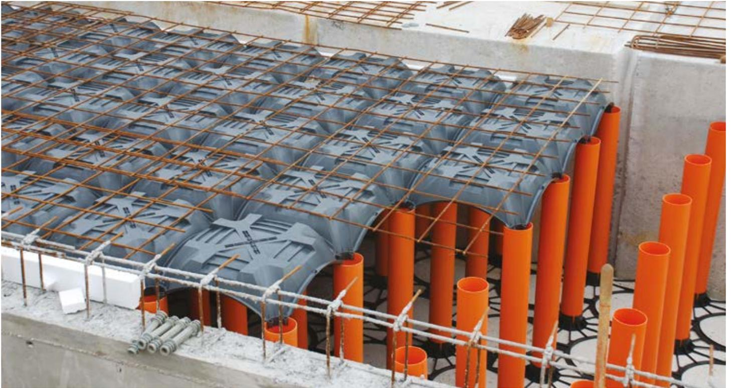
Système modulaire pour la réalisation de bassins de laminage ou d'accumulation des eaux à haute capacité.
