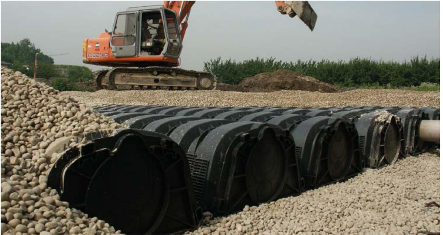
Système modulaire à haute résistance pour la réalisation des bassins de drainage ou l'accumulation des eaux pluviales de grande capacité.
