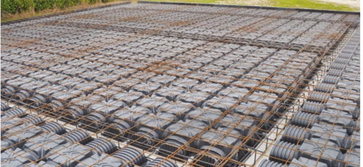
MODULO est un coffrage perdu pour la création d'un vide sanitaire qui, convenablement ventilé, permet d'éliminer les remontées d'humidité et le gaz Radon. La structure obtenue par MODULO est une série de
