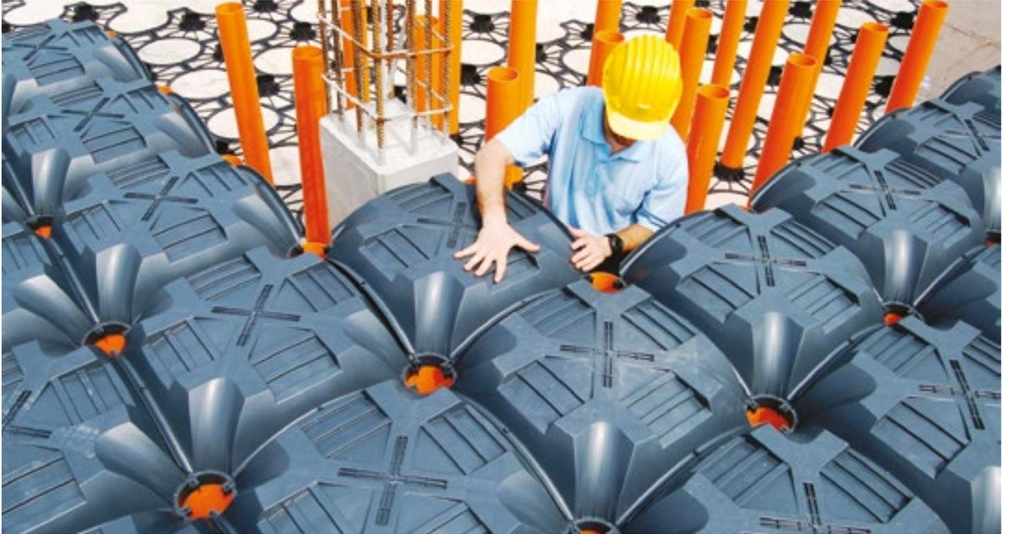
Système modulaire à perdre pour la réalisation de fondations ventilées de hauteurs jusqu'à 300 cm, qui crée une barrière physique entre le sol et le bâtiment.
