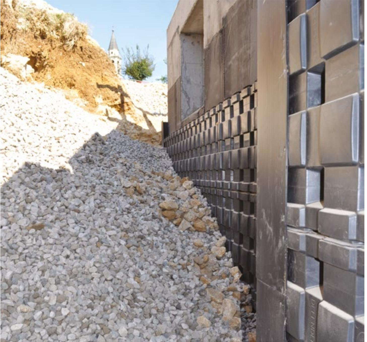
**PANNEAU MODULAIRE POUR LE DRAINAGE DE PAROIS ENTERRÉES ET PROTECTION DE L'ÉTANCHEITÉ**
