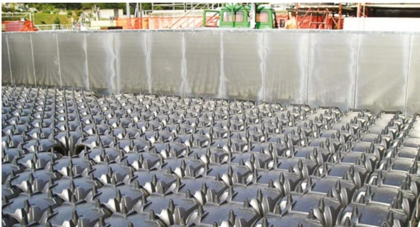
Coffrage perdu pour la réalisation de pavages perforés autoportants pour biofiltres et plateformes de compostage.
