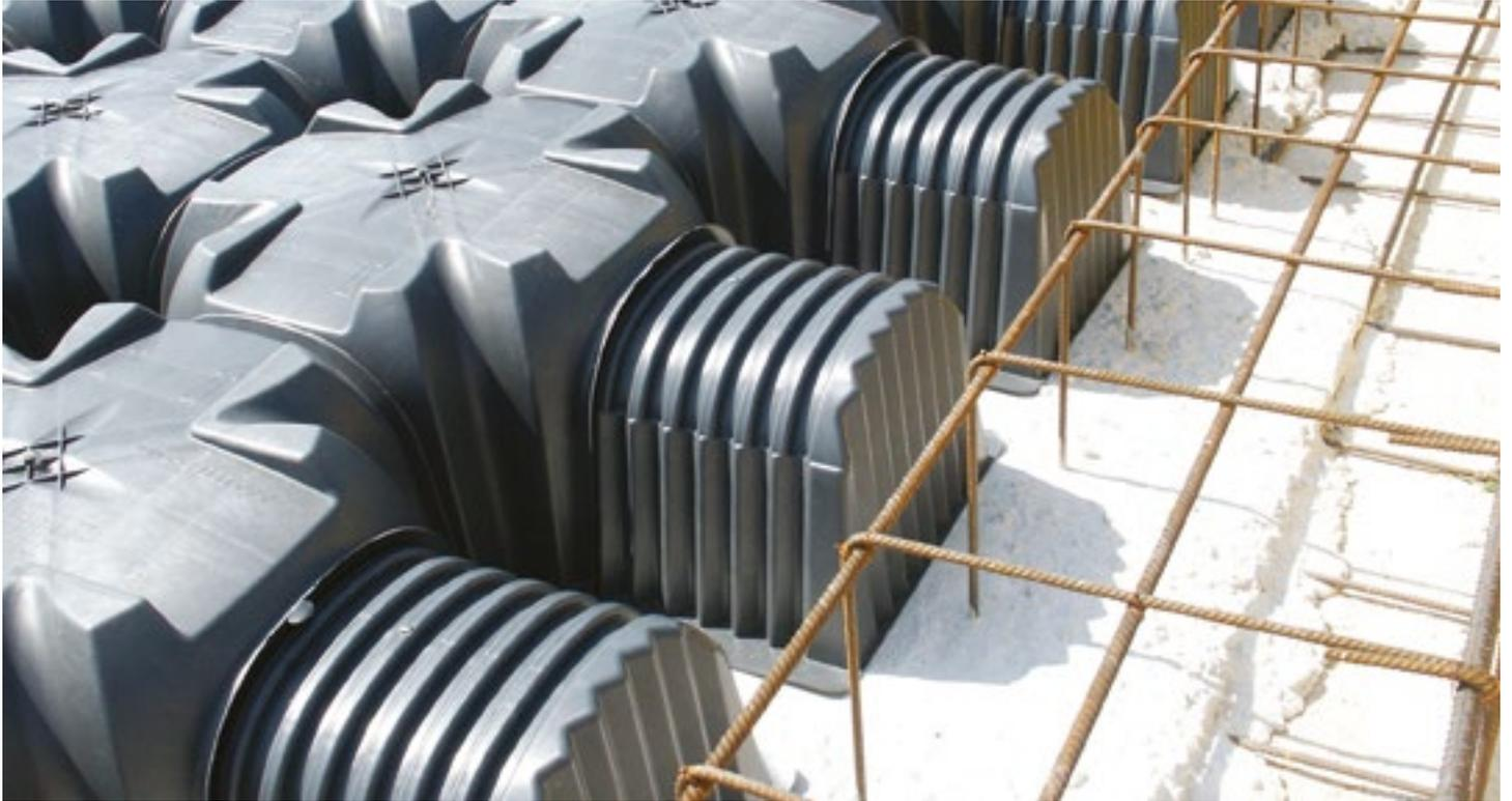
Coffrage modulaire pour la réalisation de vides sanitaires ventilés qui forme une barrière physique entre le sol et le bâtiment.
