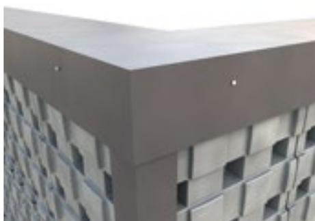
Placer la feuille de carton en plastique au dessus des panneaux DEFENDER et la fixer avec des vis à tôles.
