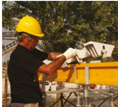
② COLOCACIÓN VIGUETAS H
