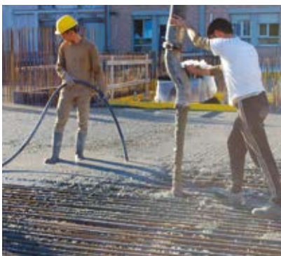
⑦ HORMIGONADO SEGUNDA FASE
