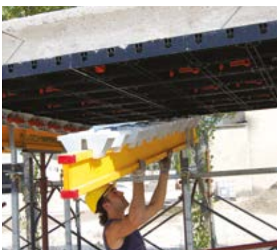
⑥ RETIRADA VIGUETA H
