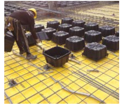
③ COLOCACIÓN NUEVO NAUTILUS
