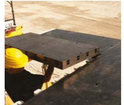
③ COLOCACIÓN PANELES GEOPANEL
