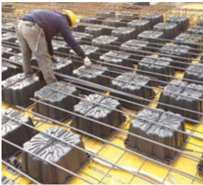
④ TERMINACIÓN COLOCACIÓN ENCOFRADO
