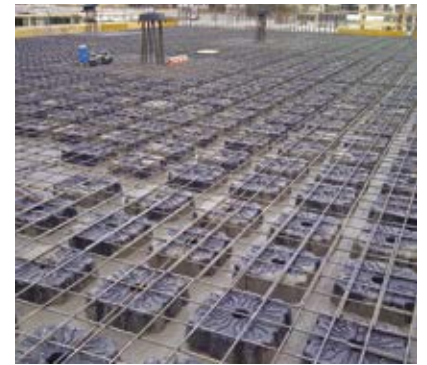
⑥ ESPERA ENTRE PRIMERA Y SEGUNDA FASE DE HORMIGONADO
