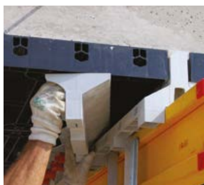
⑦ RIMOZIONE CUNEO
