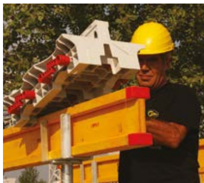
① POSA TRAVETTI Y + CUNEO
