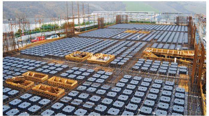
Figura 1 – forjados aligerados con Nuevo Nautilus Evo de Geoplast.
