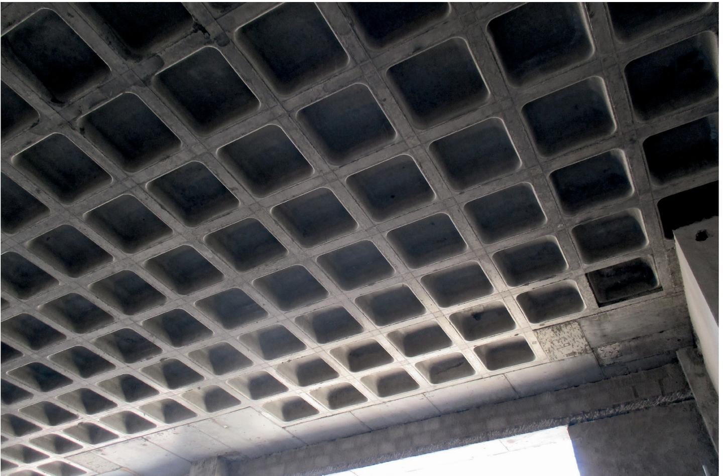
Figura 2 – ejemplo de forjado reticular
