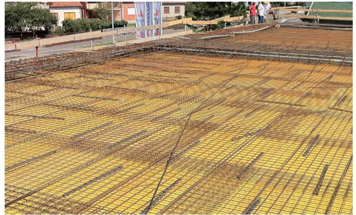
Figura 41 – colocación de la malla de refuerzo inferior
