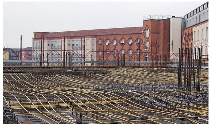
Figura 64 – cables postesados sobre losa plana
