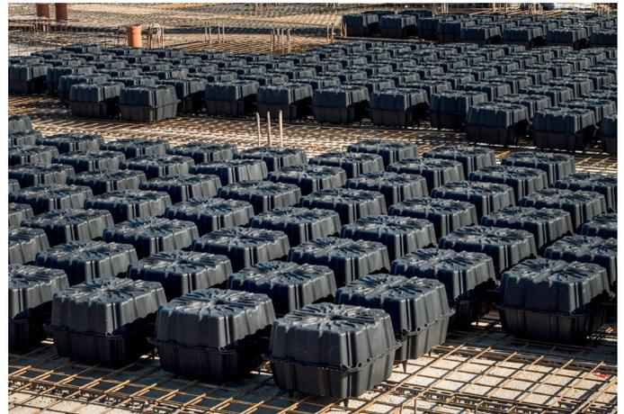
Figura 3 – colocación de aligeramientos Nuevo Nautilus Evo double
