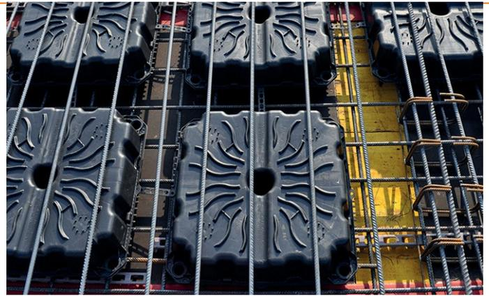
Figura 49 – colocación de las barras de refuerzo superiores
