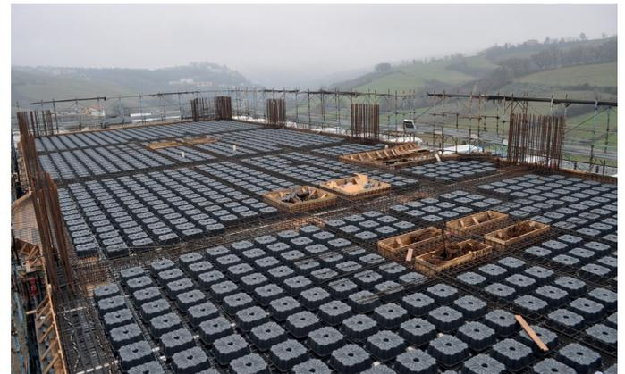
Figura 59 – preparaciones de las cavidades antes del hormigonado
