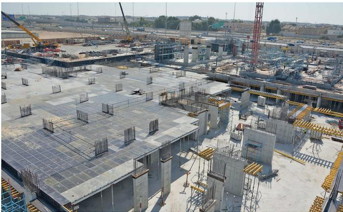
Figura 38 – encofrado del forjado hormigonado in situ con encofrados modulares de metal
