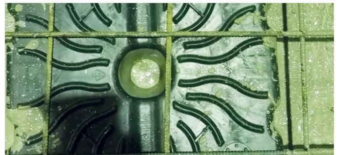
Figura 55 – cono correctamente relleno
