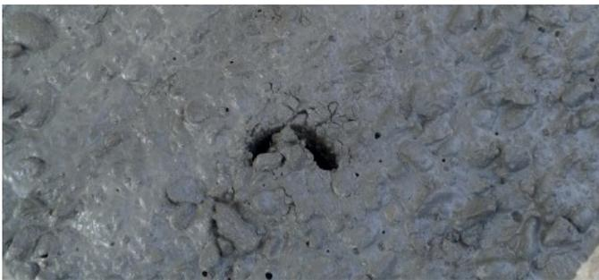
Figura 57 – la huella en el hormigón indica el momento adecuado para empezar de nuevo el hormigonado
