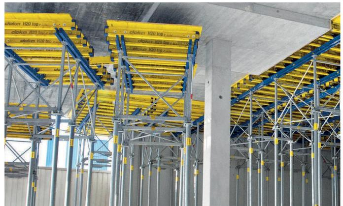
Figura 40 – encofrado de forjado colado in situ con encofrados modulares de madera
