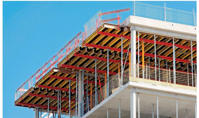
Figura 39 – encofrado de forjado colado in situ con encofrados tradicionales de madera y paneles de contrachapado
