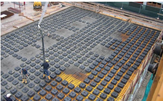
Figura 58 – hormigonado de la primera capa
