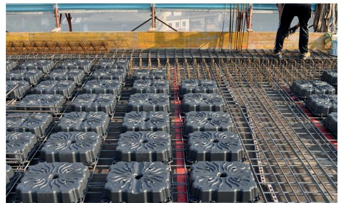
Figura 48 – correa de separación para la conexión del aligeramiento
