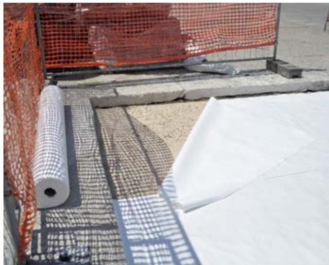
Figura 10: posa in opera del geotessuto sullo strato di misto granulare
