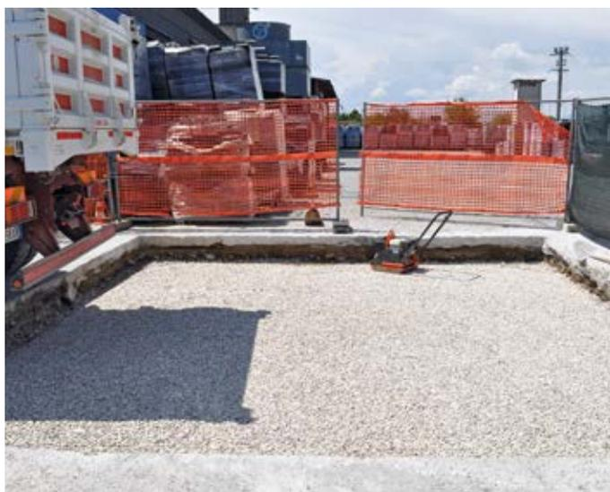
Figura 9: posa misto granulare per strato di base
