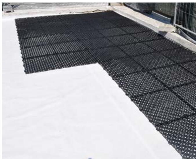
Figura 11: posa in opera della griglia Geocell
