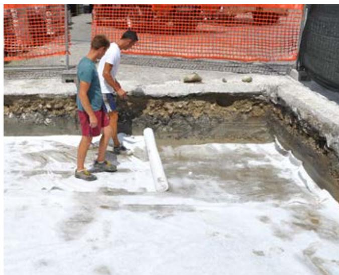
Figura 8: posa del geotessuto sul fondo dello scavo
