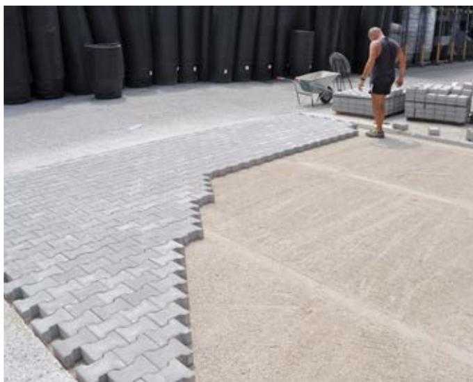
Figura 14: stesura dello strato di sabbia di allettamento e posa dei masselli autobloccanti
