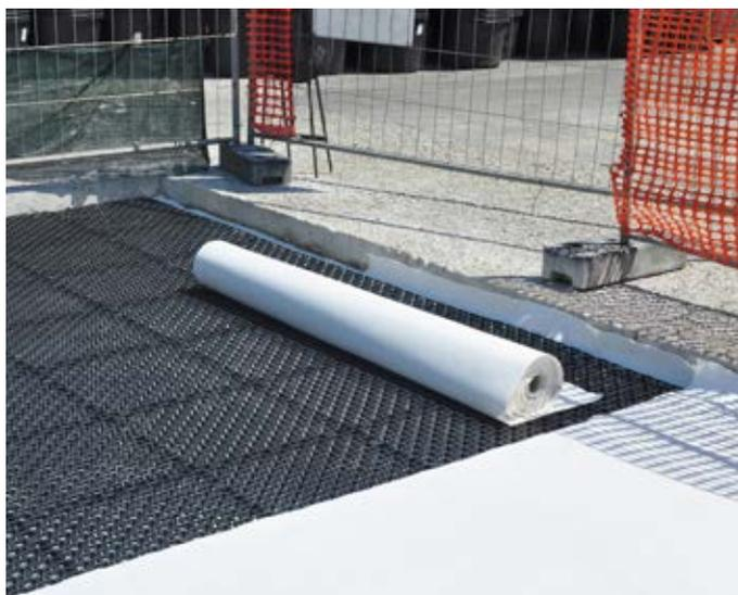
Figura 13: posa del geotessuto al di sopra del Geocell
