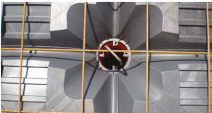
Für besondere Situationen, in denen die Kombination aus Lasten und sehr langen Rohren besonders schwierig ist, ist es ratsam in die Rohre Eisenelemente (Leisten/Gabeln aus Stahl) einzufügen, um die Stabilität der Betonsäule auch unter dynamischen Belastungen aufrechtzuerhalten.
