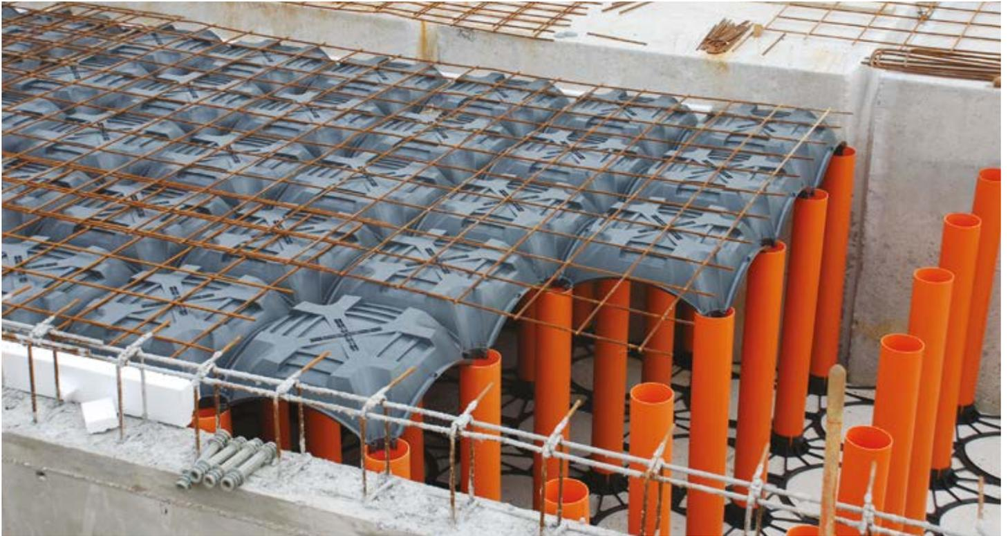
Modulares System zur Errichtung von Absetzungs- oder Auffangbecken für Wasser mit einem hohen Fassungsvermögen.
