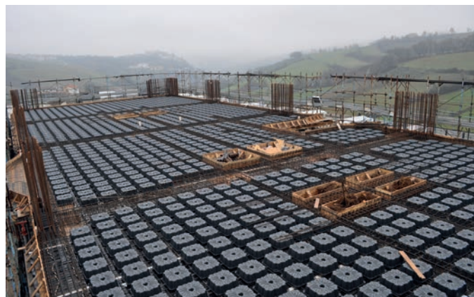
Figura 59 - preparazione cavedi prima del getto
