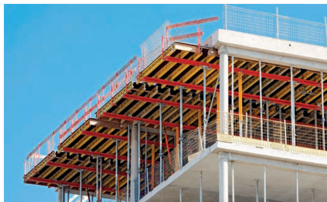
Figura 39 - cassetta di piastra gettata in opera con casseforme tradizionali in legno e pannelli in compensato
