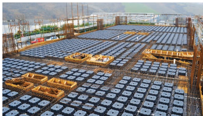
Figura 1 - solaio alleggerito con Nuovo Nautilus Evo di Geoplast.
