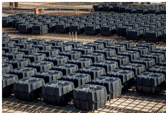
Figura 3 - layout di alleggerimenti Nuovo Nautilus Evo double
