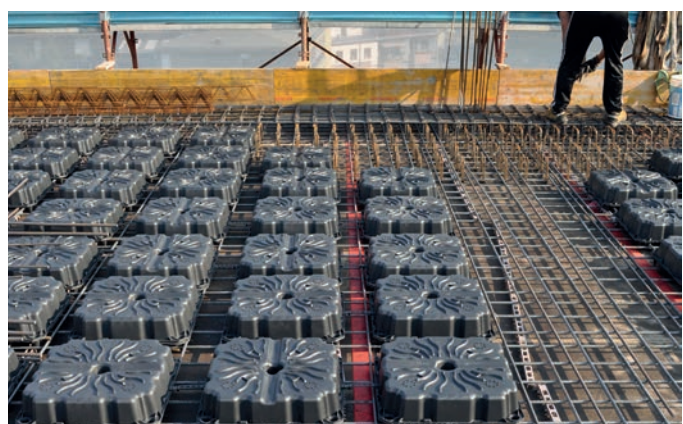
Figura 46 - layout degli alleggerimenti
