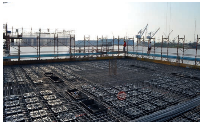
Figura 50 - posa delle barre di armatura superiore
