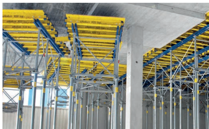
Figura 40 - cassetta di piastra gettata in opera con casseforme modulari legno
