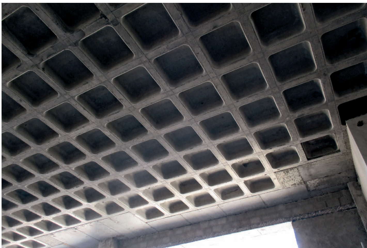
Figura 2 - esempio di solaio reticolare
