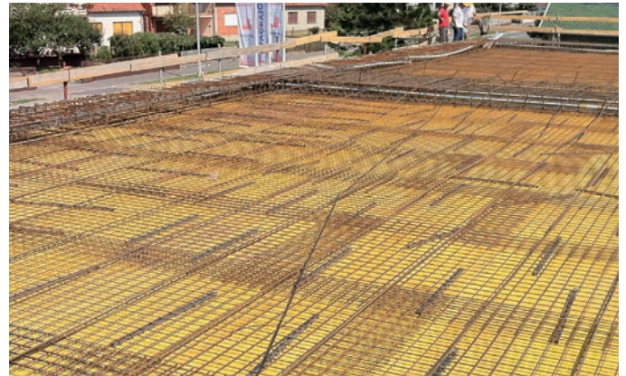
Figura 41 - posa della maglia inferiore di armatura
