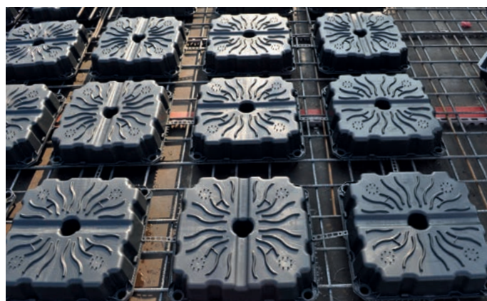
Figura 47 - layout degli alleggerimenti
