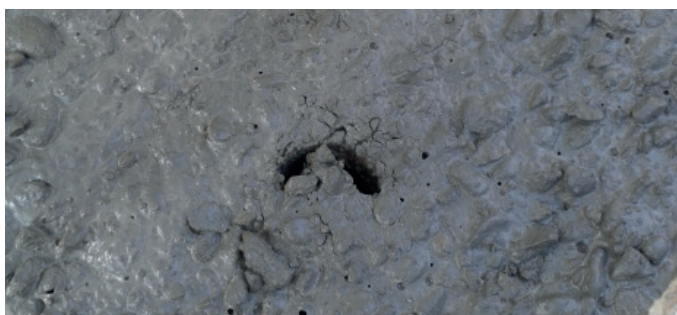
Figura 57 - l'impronta nel calcestruzzo indica il momento giusto per riprendere il getto
