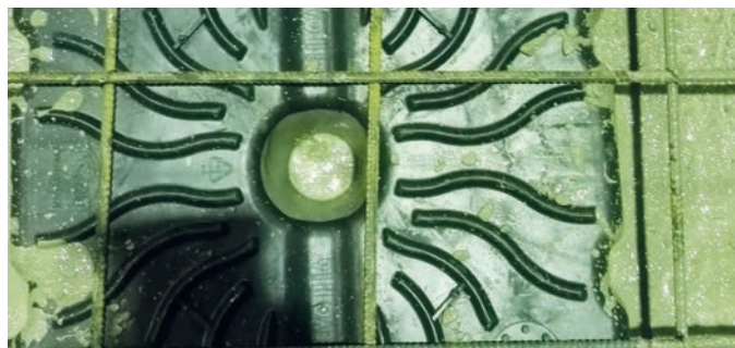
Figura 55 - cono correttamente riempito
