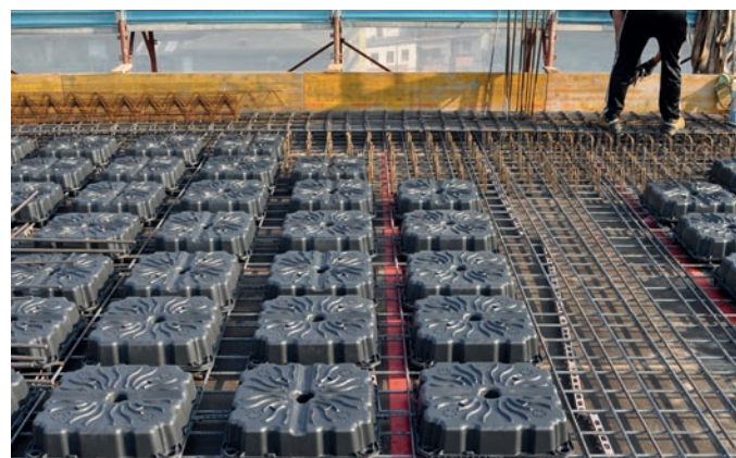
Figura 48 - cinghietta distanziatrice per il collegamento degli alleggerimenti
