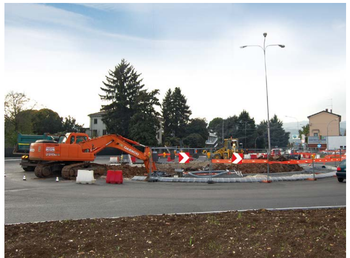
⑤ Lavori finali di riposizionamento cordoli e piantumazione vegetali.
