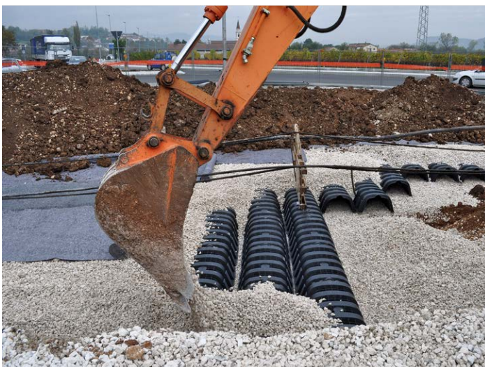
③ Ricoprimento dei moduli Drening con ghiaia.
