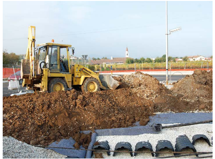
④ Ricoprimento rotatoria con terra e idonea stratigrafia.
