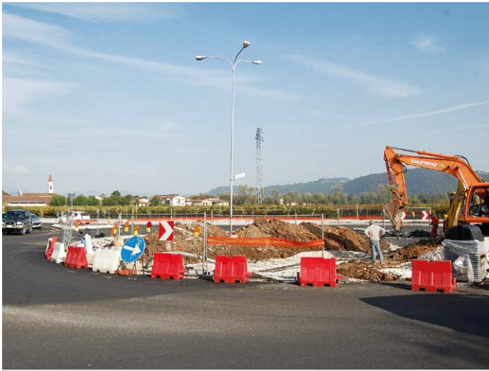
① Lavori di sbancamento e splattamento.
