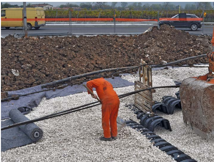
② Posa letto di ghiaia, geotessuto e moduli Drening.
