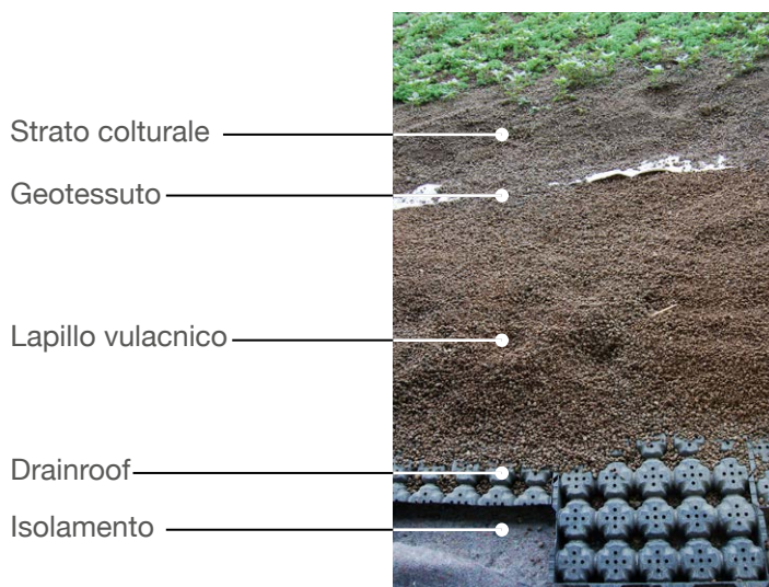
Figura 16 - Stratigrafia tipo
