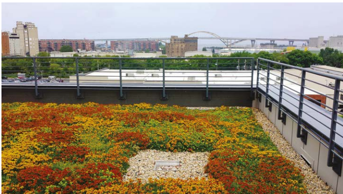
Figura 22 -Esempio pensile estensivo su copertura Industriale
