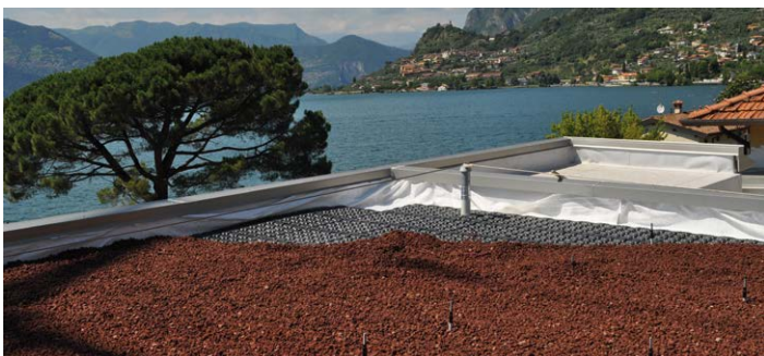
Figura 20 - Uso combinato Drainroof e lapillo vulcanico
