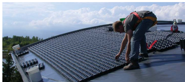
Figura 12 - Installazione Drainroof
