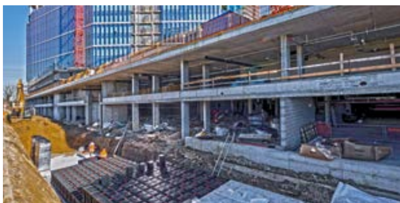
Regenwasser-Versickerungsbecken (1000 m 3 ) Installationsphase der Module BUSINESS CENTER, MAILAND, ITALIEN
