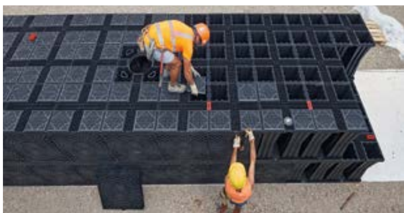
Regenwasser-Versickerungsbecken (130 m 3 ) Obere Modulabschlussphase NEUE BEWOHNUNG, TRENTO, ITALIEN
