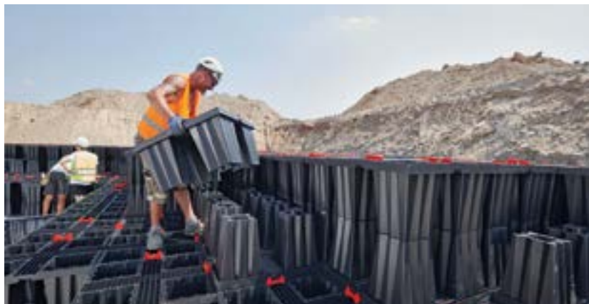
Regenrückhaltebecken (800 m 3 ) Installationsphase der Module FLUGHAFEN ORIO AL SERIO, BERGAMO, ITALIEN
