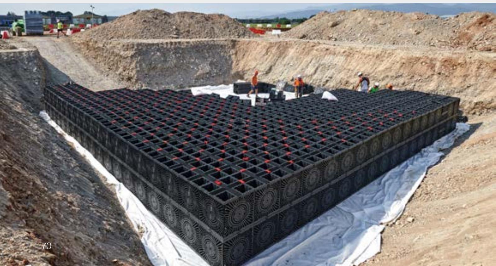
**ELEMENTO MODULARE A STRUTTURA TRONCOPIRAMIDALE CAVA**
