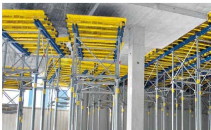
*Figura 40 - casseratura di piastra gettata in opera con casseforme modulari legno*
