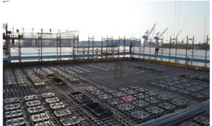
Figura 50 - posa delle barre di armatura superiore
