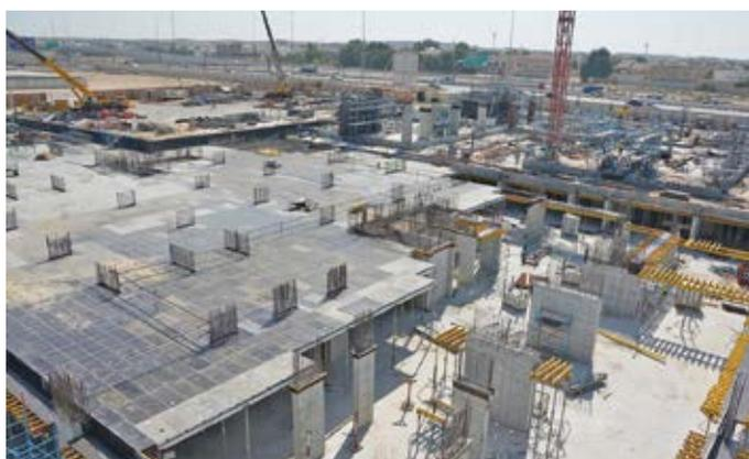
*Figura 38 - casseratura di piastra gettata in opera con casseforme modulari in metallo*
