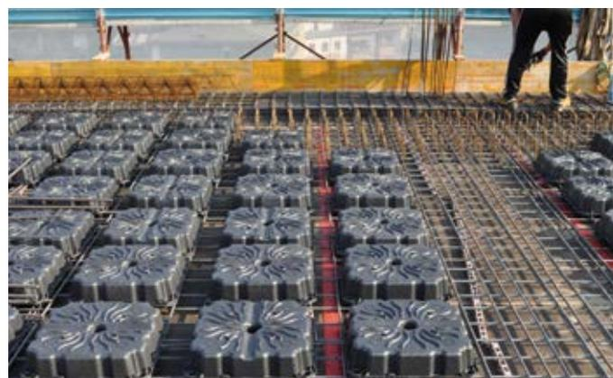
Figura 48 - cinghietta distanziatrice per il collegamento degli alleggerimenti
