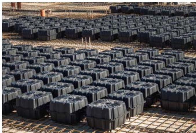
Figura 3 - layout di alleggerimenti Nuovo Nautilus Evo double
