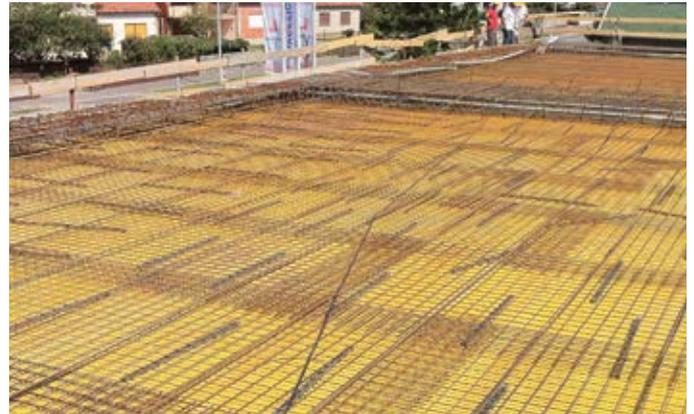
Figura 41 - posa della maglia inferiore di armatura
