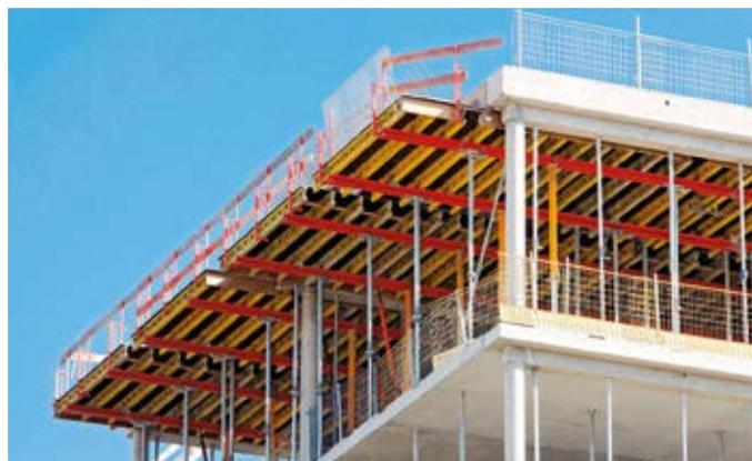
*Figura 39 - casseratura di piastra gettata in opera con casseforme tradizionali in legno e pannelli in compensato*
