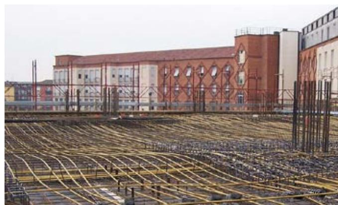
Figura 64 - cavi di post tensione su solaio a piastra
