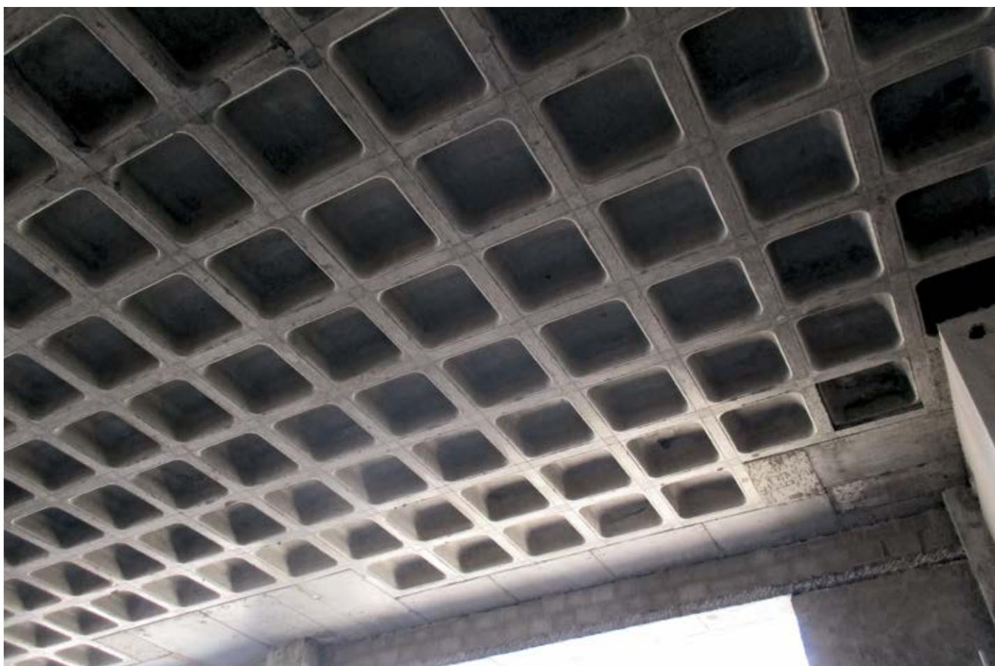
Figura 2 - esempio di solaio reticolare
