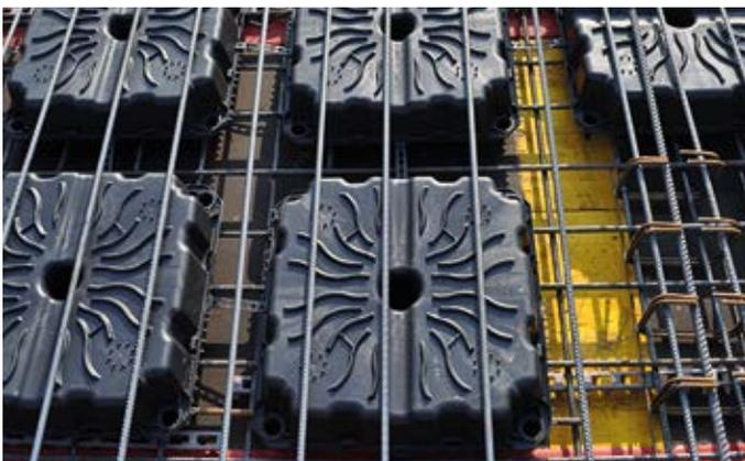
Figura 49 - posa delle barre di armatura superiore
