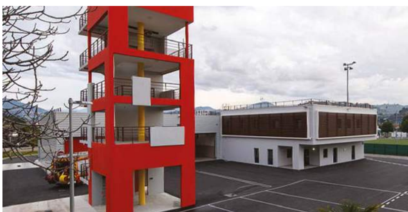
ELEVATOR TANK Centre anti-incendie et de secours SAINT-LAURENT-DU-VAR, FRANCIE
