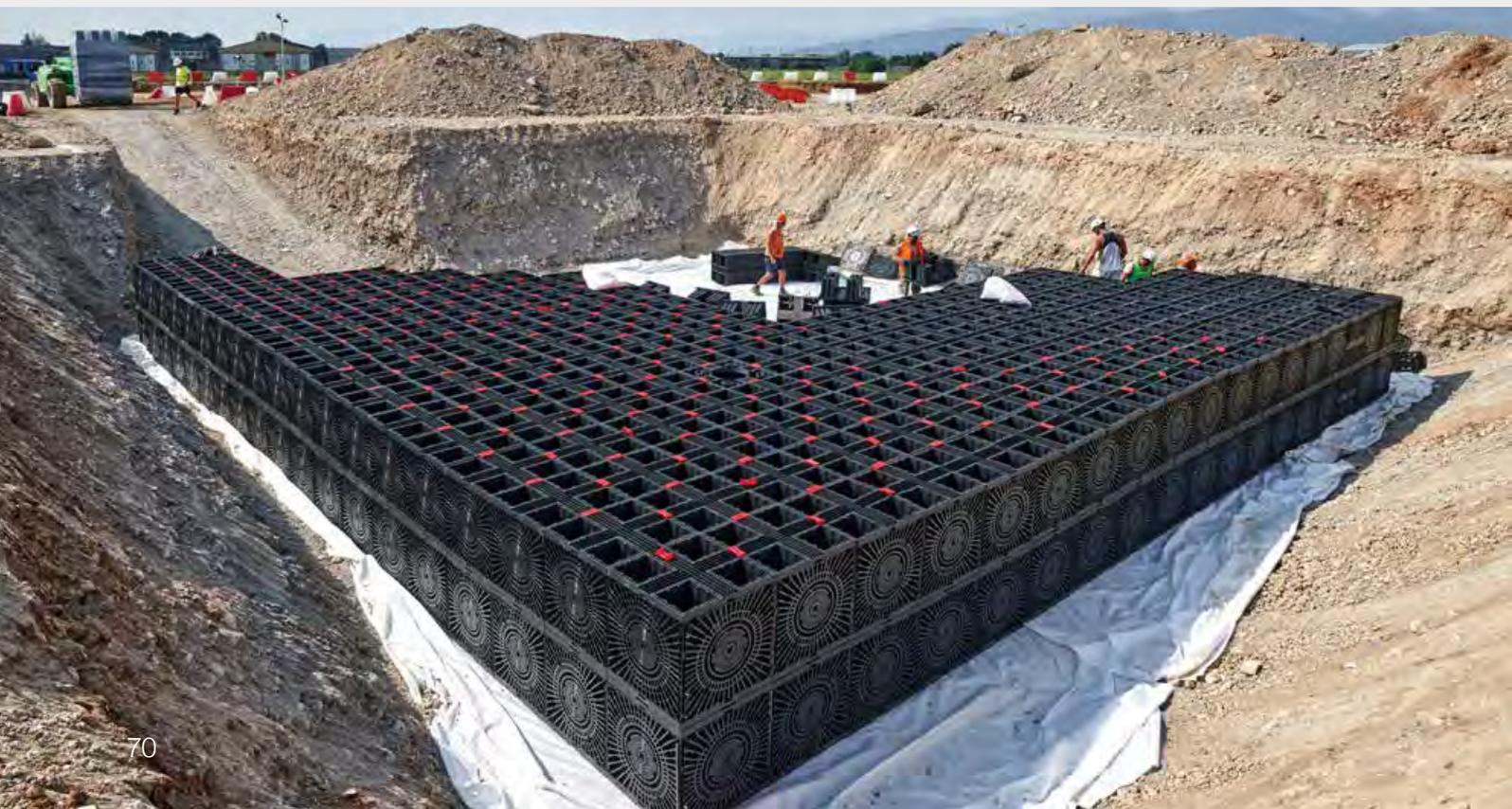
**ELEMENTO MODULARE A STRUTTURA TRONCOPIRAMIDALE CAVA REALIZZATO IN POLIPROPILENE VERGINE O RICICLATO. È PROGETTATO PER REALIZZARE BACINI INTERRATI PER LA GESTIONE SOSTENIBILE DELLE ACQUE METEORICHE.**
