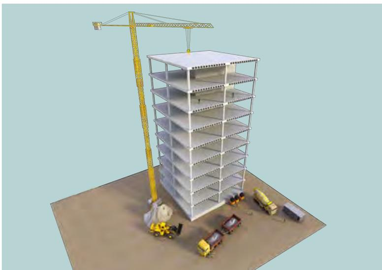
Alleggerire la struttura dell'edificio migliorandone la risposta sismica riducendo il consumo di calcestruzzo e ferro: le casseforme per solai Geoplast sono molto veloci da installare sia per solai mono che bidirezionali.
