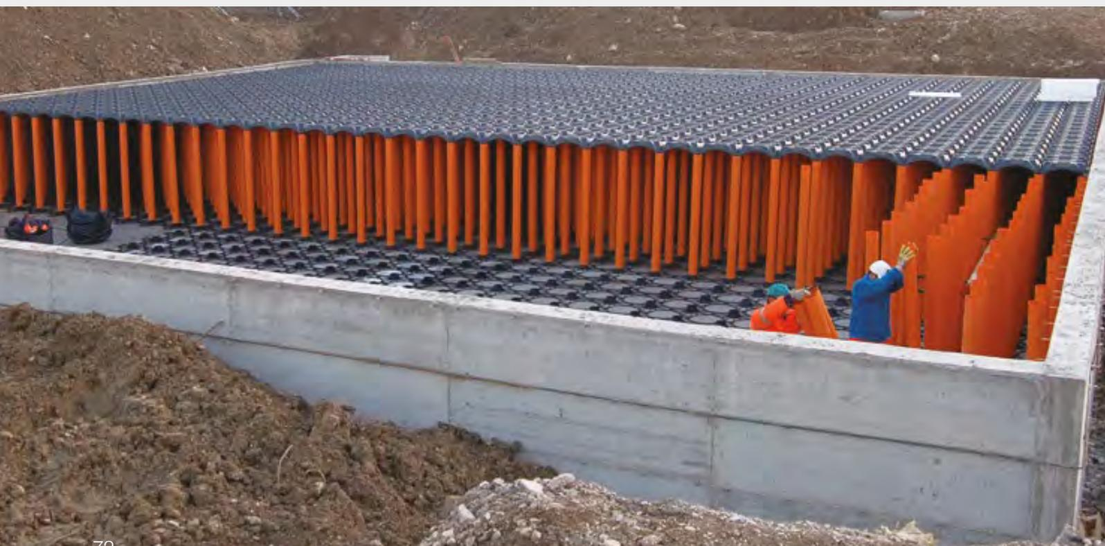
**SISTEMA IN MATERIALE PLASTICO RICICLATO CHE PERMETTE DI REALIZZARE VASCHE IN CALCESTRUZZO PER LA RACCOLTA O DISPERSIONE DELLE ACQUE METEORICHE. L'ALTEZZA E LE DIMENSIONI DELLE VASCHE SONO VARIABILI A SECONDA DELLE ESIGENZE PROGETTUALI.**
