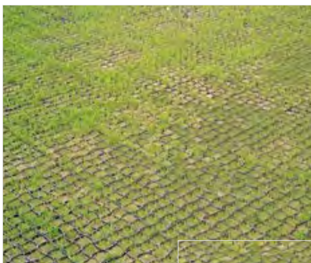
Area verde con Runfloor 58 F03 adibita al passaggio e sosta di mezzi di servizio.
